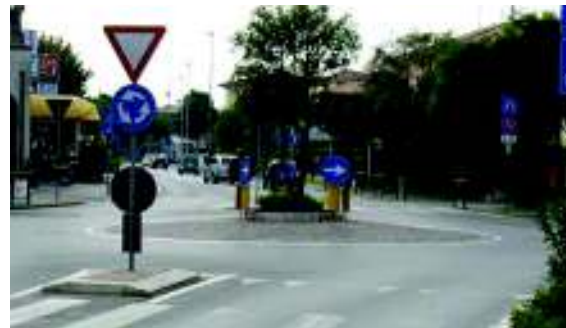
Esempio di mini-rotatoria con corona sormontabile
