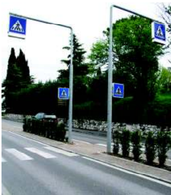
esempio di attraversamento pedonale protetto
